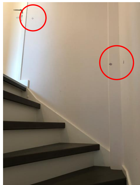
Zet een markering aan het begin en einde van elke wand
